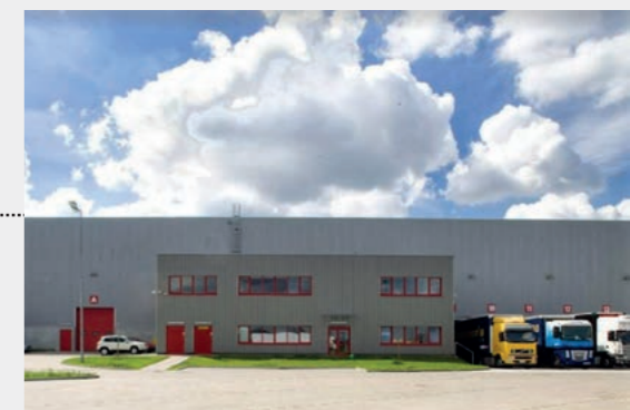
HUB PRZEŁADUNKOWY ŁYSOMICIE
